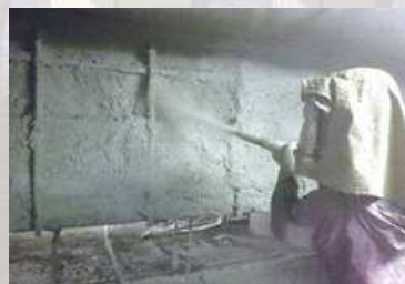
補修中（リフレドライショット工法）
