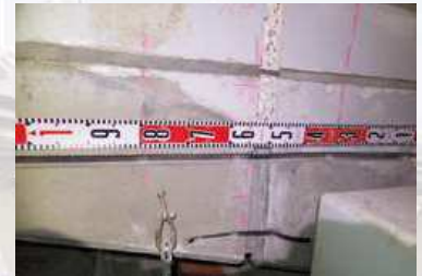
補修中（エルガード工法）
