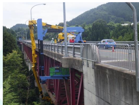
橋梁点検車を用いた点検状況
