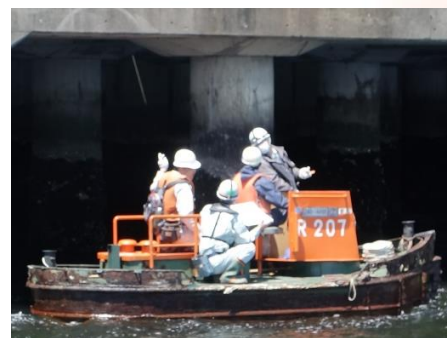
調査船を用いた点検状況
