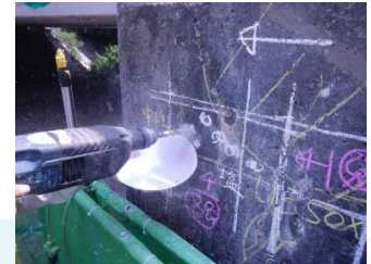
ドリル削孔状況
