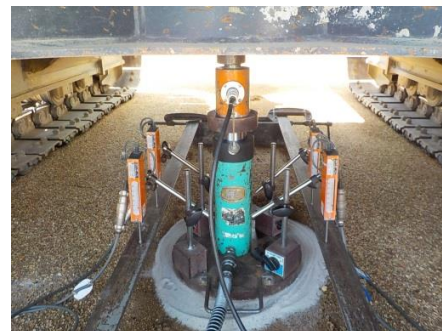
試験装置(オイルジャッキ・荷重計・変位計)
