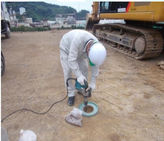
試験状況(試験孔 削孔状況)
