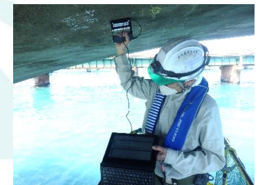
部材厚さ 測定状況
