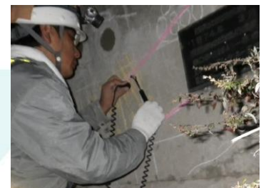
グラウト充填度 測定状況
