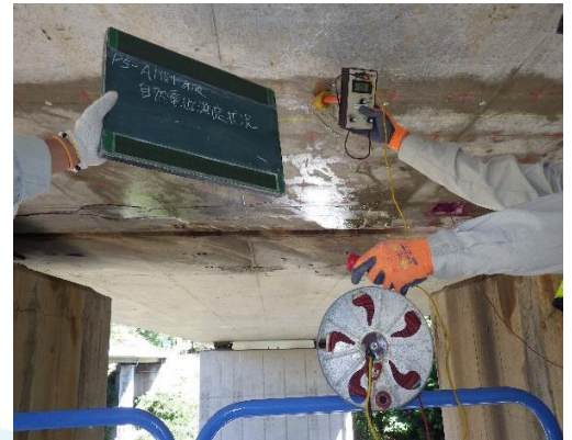
写真-2. 自然電位測定状況
