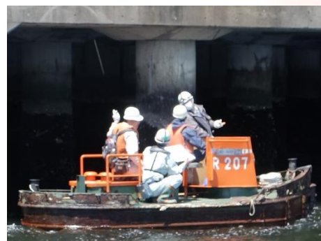
調査船を用いた点検状況
