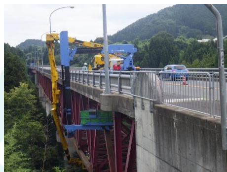
橋梁点検車を用いた点検状況
