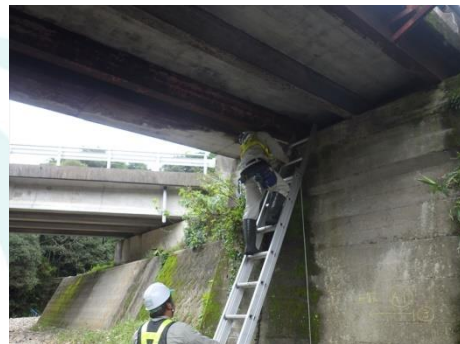
2段梯子を用いた点検状況
