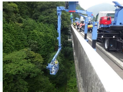
高所作業車による寸法計測
