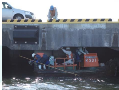
ボートによる寸法計測
