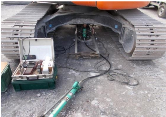
試験状況(反力:バックホウ使用)
