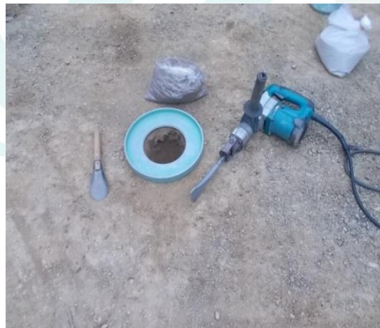
試験状況(試験孔 削孔完了)
