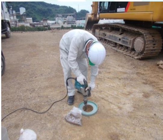
試験状況(試験孔 削孔状況)
