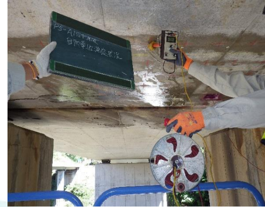
写真-2. 自然電位測定状況
